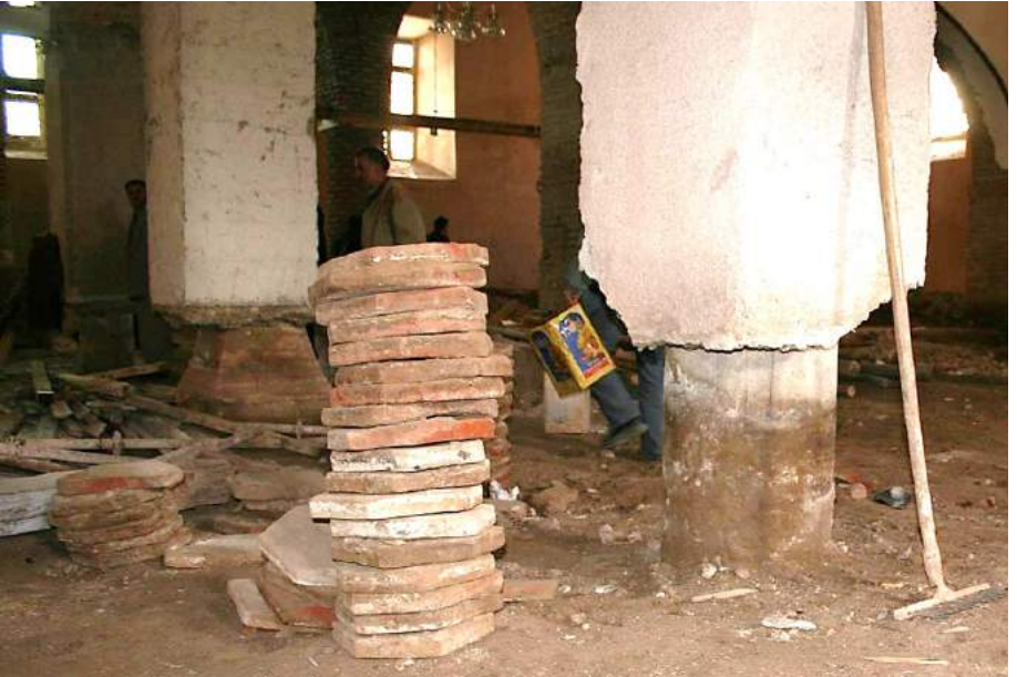
Fotoğraf 17: Tuğla zemin döşemesi (Konya Vakıflar B. M. Arşivinden)
