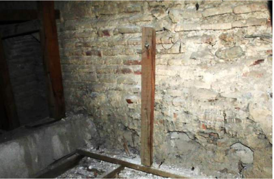
Fotoğraf 13: Özgün tuğla duvar dokusu (Konya Vakıflar B. M. Arşivinden)
